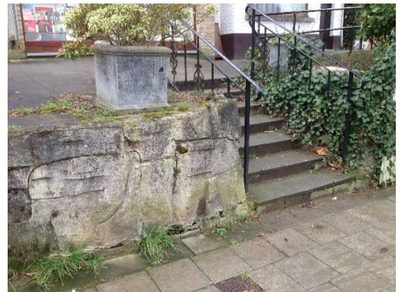
Muret en rocaille et escalier en moellons, d'un ancien jardinet à front de voirie.
