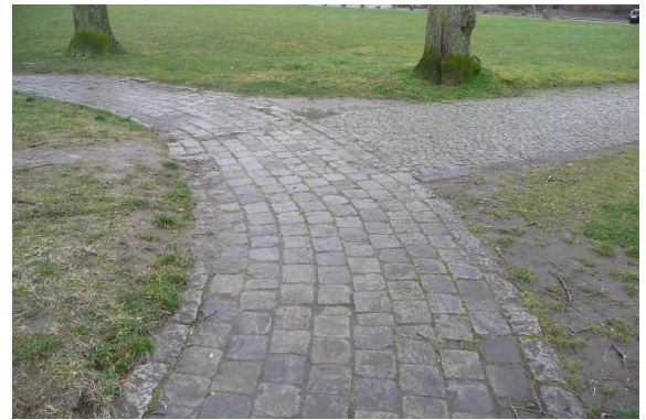
Les traversantes en pavés de pierre
